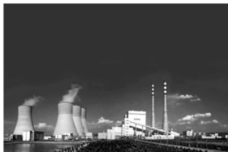
图 4-1-5 安装除尘装置的工厂
