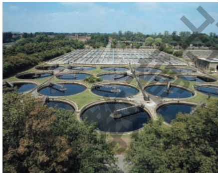
集中处理工业废水
