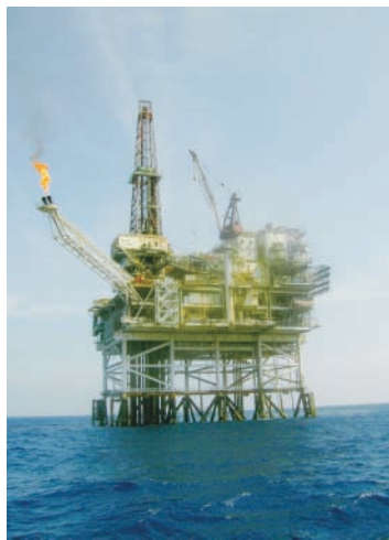
渤海湾海上石油井架
