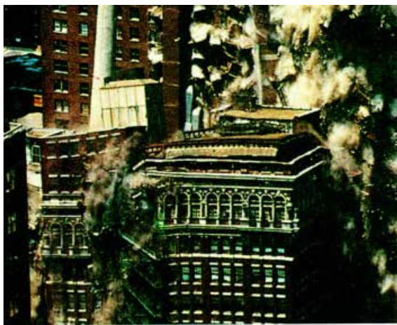
图 1-2-5 被地震毁坏的大厦
