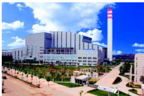
图 3-3-7 常州市城市生活垃圾焚烧发电厂
