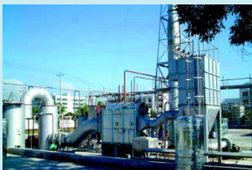
图 4-1-1 垃圾焚烧炉
